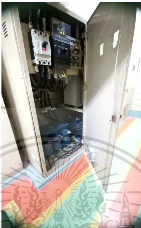
รูปที่ ข.6 ภายในของวงจรรองแบบพาสซีฟที่ MDB1 ของโรงงานที่ 5
