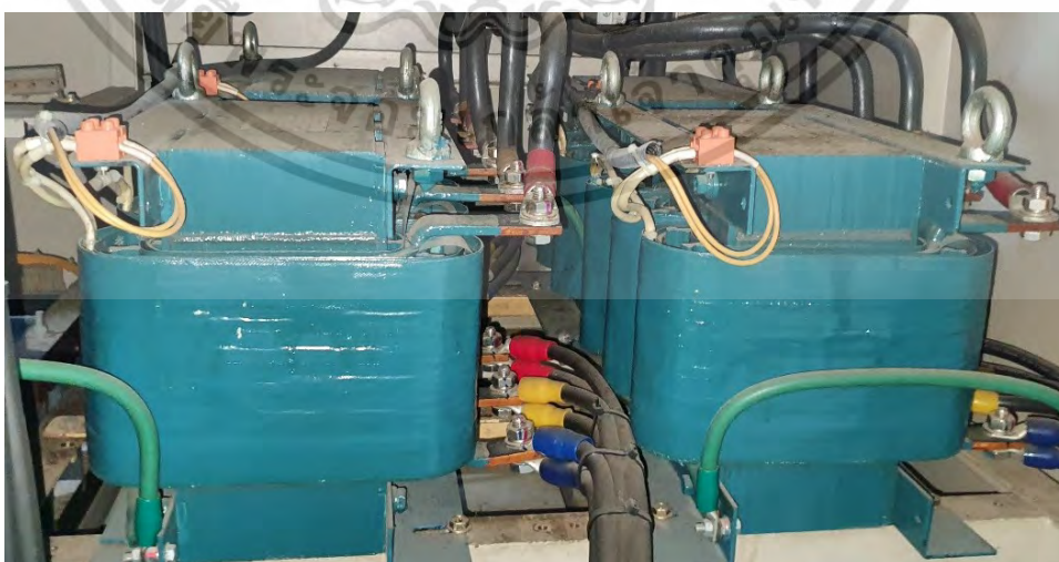
รูปที่ 3.3 ตัวอย่างตัวเหนี่ยวนำ (Reactor) ในอุตสาหกรรม
