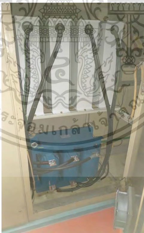
รูปที่ ข.7 ตัวเก็บประจุและตัวเหนี่ยวนำของวงจรรองแบบพาสซีฟที่ MDB1 ของโรงงานที่ 5
