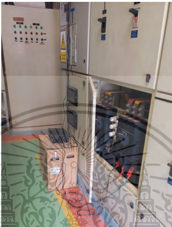
รูปที่ ข.4 การสำรวจและเก็บข้อมูลด้วยเครื่องมือวัด Class A ที่ MDB1 ของโรงงานที่ 5
