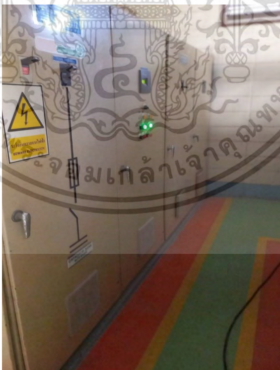
รูปที่ ข.5 วงจรกรองแบบพาสซีฟที่ติดตั้งที่ MDB1 ของโรงงานที่ 5
