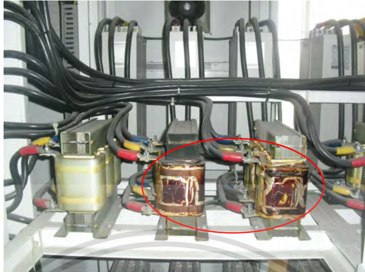
รูปที่ 4.1 ความเสียหายของรีแอคเตอร์ของวงจรกรองฮาร์มอนิก (ต่อ)
