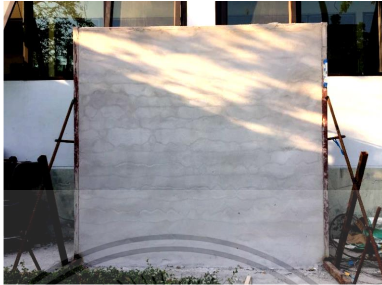
รูปที่ 3.2 ผนังก่ออิฐมวลเบาที่ไม่มีการเสริมกำลัง (ชิ้นงานทดสอบ)
