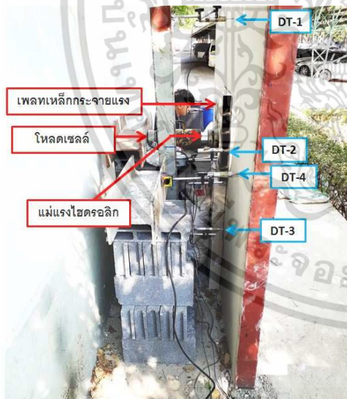
รูปที่ 3 ลักษณะการติดตั้งอุปกรณ์ที่ใช้ทดสอบและเครื่องมือวัด
