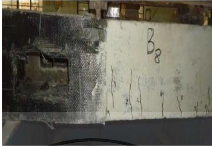
รูปที่ 2.9.5 CFRP wrapping around and inside the opening 1
