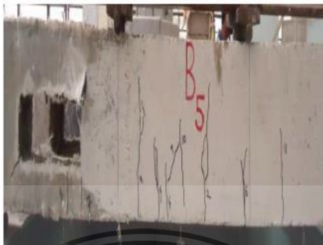
รูปที่ 2.9.8 CFRP wrapping around the opening by double layer 2
