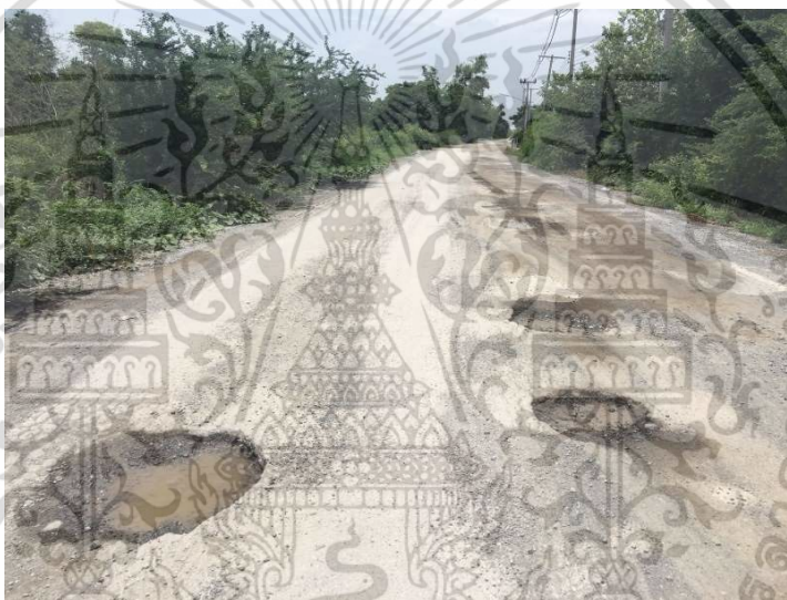
รูปที่ 2.12 ความเสียหายประเภทหลุมบ่อ (บริษัท มติชน จำกัด (มหาชน), 2559)
