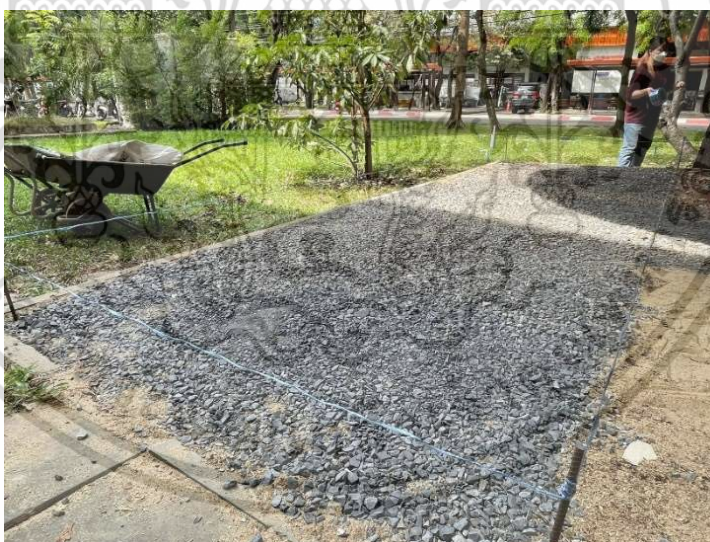
รูปที่ 3.17 ปรับระดับพื้นสนามทดสอบด้วยกรวด
