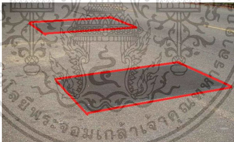
รูปที่ 2.16 ความเสียหายประเภทรอยปะซ่อม (กรมทางหลวงชนบท, 2562)
