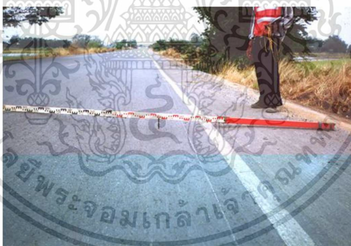
รูปที่ 2.14 ความเสียหายประเภทร่องล้อ (จตุรงค์, 2555)
