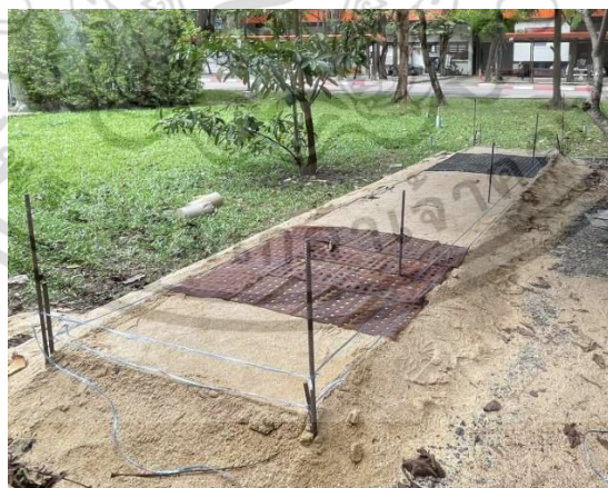
รูปที่ 3.19 แสดงการติดตั้ง settlement plate ที่ระดับความสูง 0.5 เมตรจากผิวดิน พร้อมติดตั้งวัสดุเสริมกำลัง
