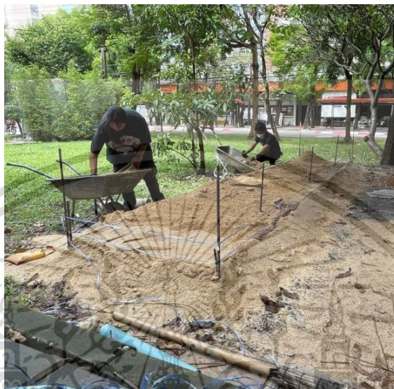
รูปที่ 3.20 สร้างสนามทดสอบด้วยชั้นทรายบดอัด
