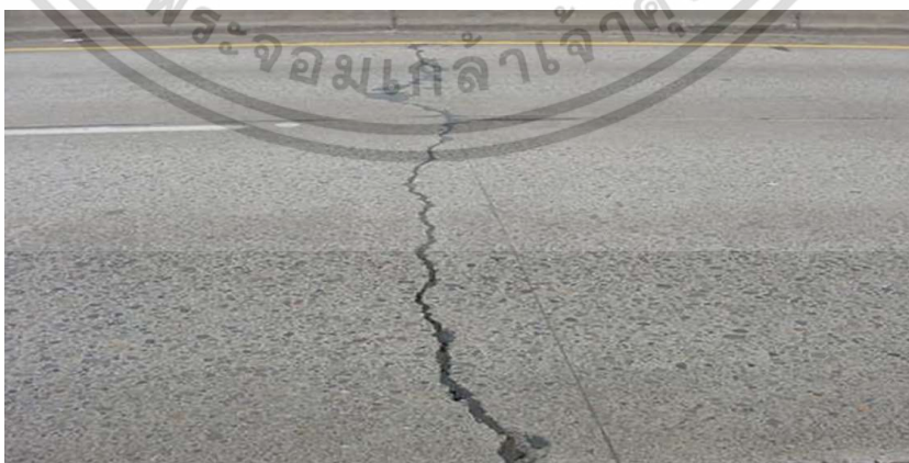
รูปที่ 2.22 ความเสียหายประเภทรอยแตกร้าวตามแนวยาว (กรมทางหลวงชนบท, 2562)
