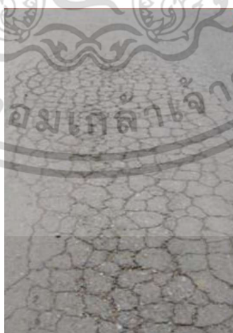
รูปที่ 2.24 ความเสียหายประเภทรอยแตกร้าวแบบหนังจระเข้ (กรมทางหลวงชนบท, 2562)
