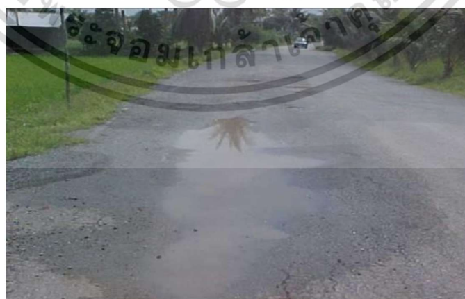
รูปที่ 2.20 ความเสียหายประเภทหลุมตื้นเป็นแอ่ง (กรมทางหลวงชนบท, 2562)
