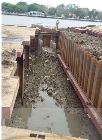
ภาพที่ 2.15 การใช้เข็มป้องกันดินพังในงานก่อสร้างอาคาร
