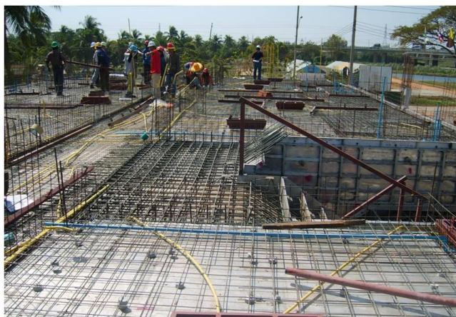
ภาพที่ 2.17 การใช้ตะแกรงเหล็กสำเร็จรูปในงานก่อสร้าง
