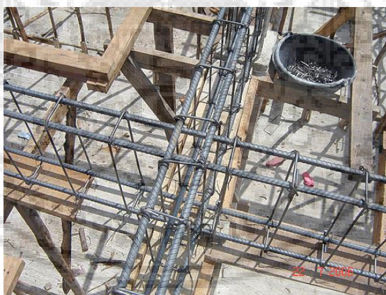
ภาพที่ 12 ตัวอย่างการนำเหล็กข้ออ้อยไปใช้ในงานก่อสร้าง
