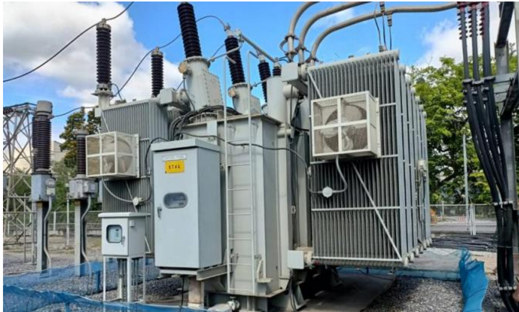
รูปที่ 4.14 หม้อแปลงไฟฟ้ากำลังขนาด 50 MVA
