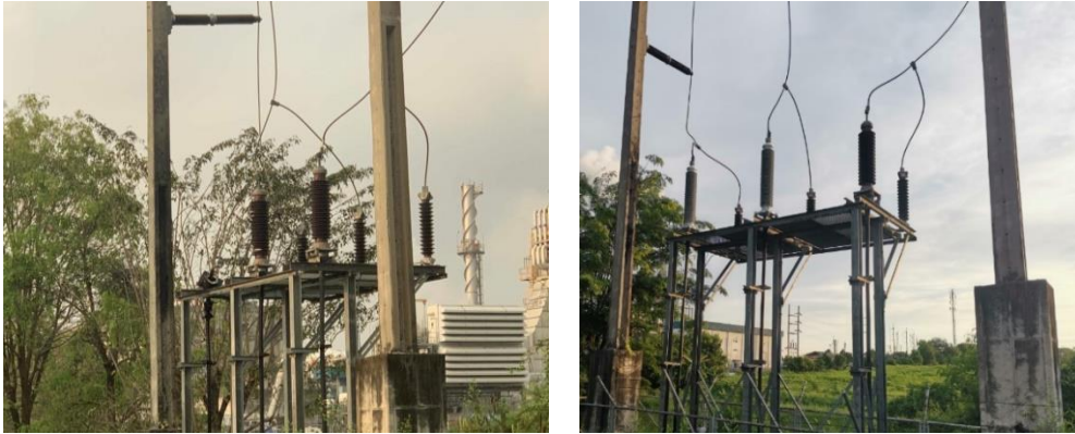
รูปที่ 2.5.24 หัวสายเคเบิล 115 kV เกิดการเบรกดาวน์และแก้ไขปัญหา
