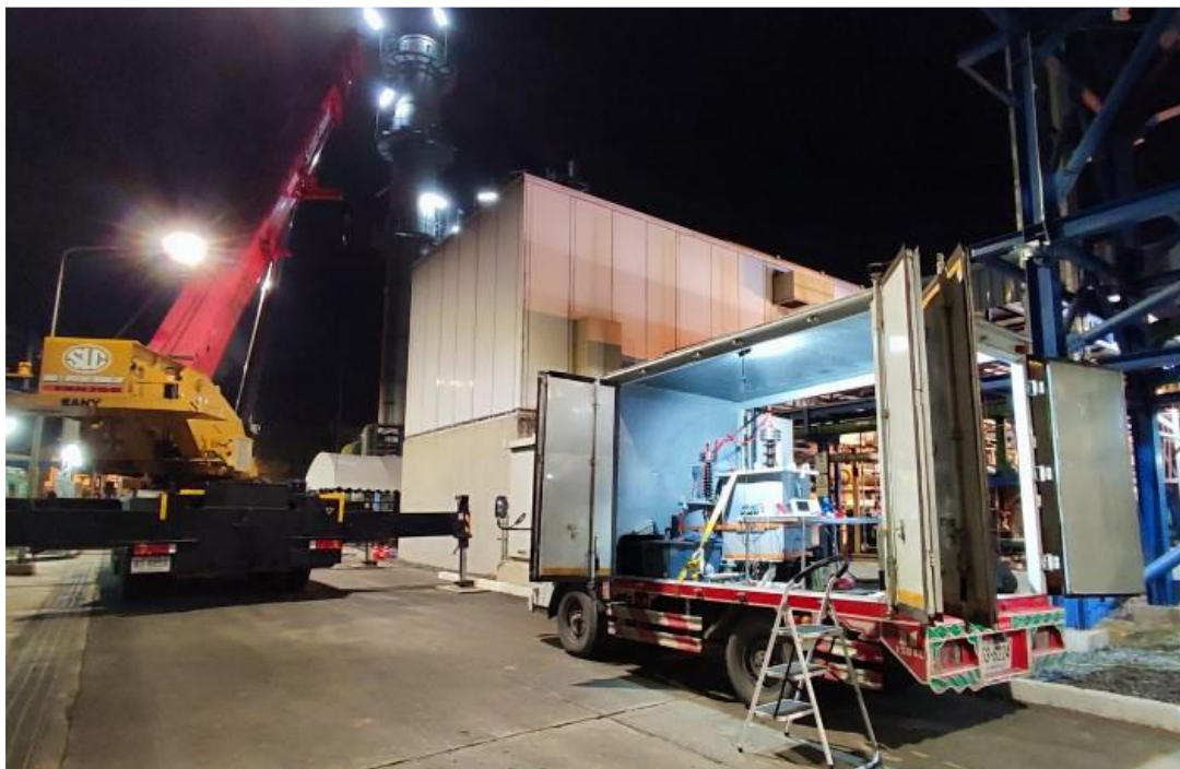
รูปที่ 4.6 การวัด PD ในเครื่องกำเนิดไฟฟ้าแบบหยุดทำงานจ่ายไฟ
