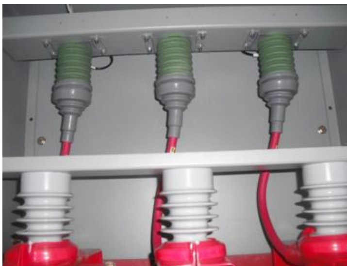
รูปที่ 2.7.4 ตัวเก็บประจุคาบเกี่ยวที่ทำจากอีพ็อกซีไมก้า (EMC)
