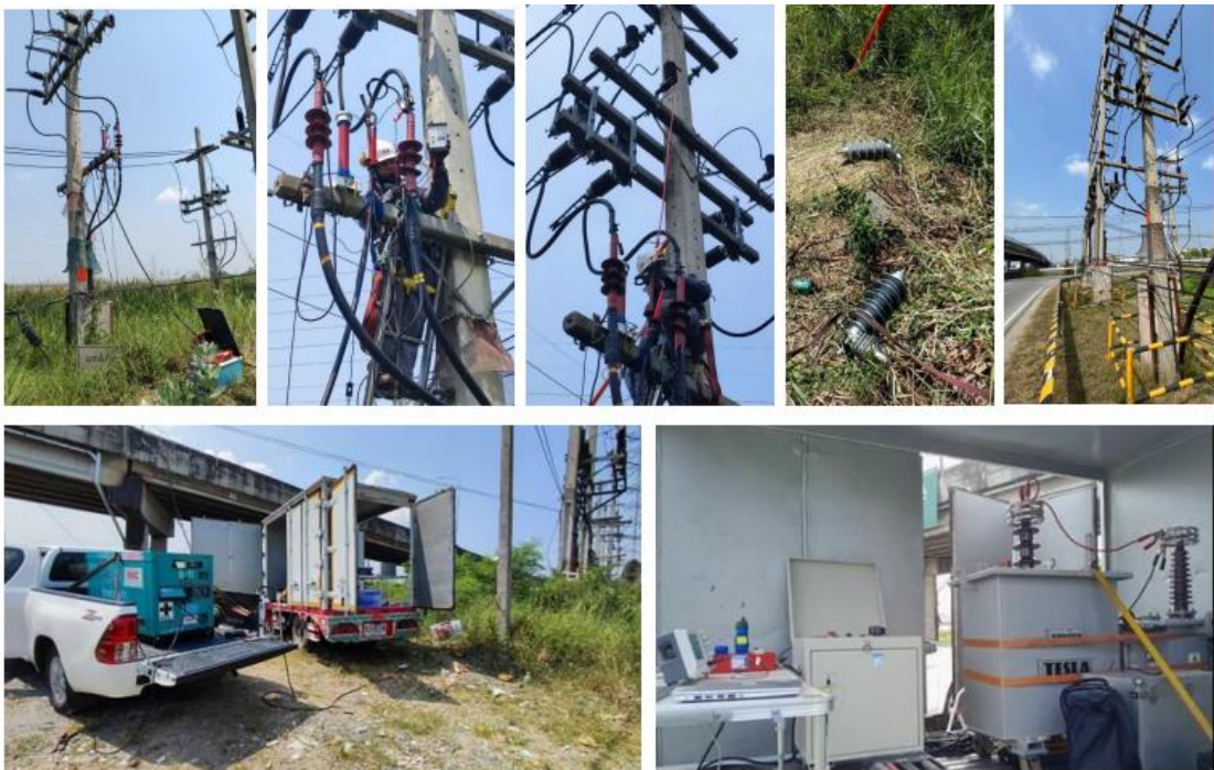
รูปที่ 4.22 การเตรียมการวัด PD แบบไม่จ่ายไฟโดยปลดสายเคเบิล
