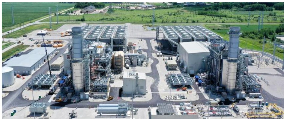
รูปที่ 1.1 โรงผลิตไฟฟ้าในปัจจุบัน [4]
