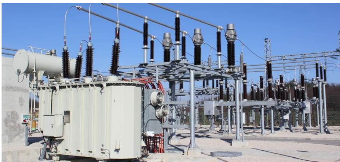
รูปที่ 2.8.16 การติดตั้งหม้อแปลงแรงดันในสถานีไฟฟ้า
