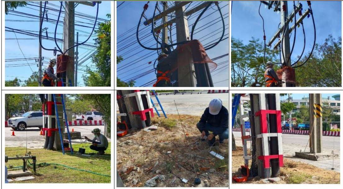
รูปที่ 4.19 การวัด PD ในสายเคเบิลแรงดันปานกลางแบบฝังดิน
