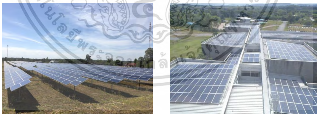
รูปที่ 2.8 โรงไฟฟ้าพลังงานแสงอาทิตย์และพลังงานแสงอาทิตย์ที่ติดตั้งบนหลังคา [16]
