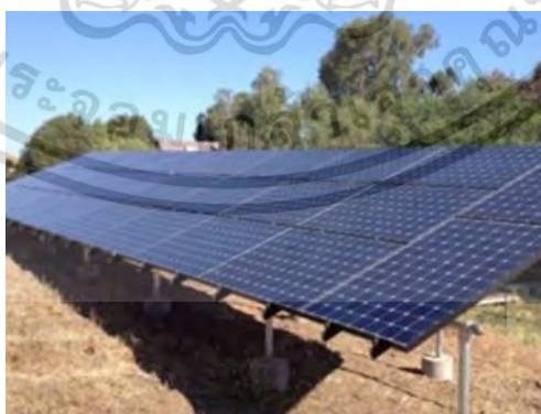
รูปที่ 2.39 ตัวอย่างลักษณะการติดตั้งบนพื้นดิน [20]
