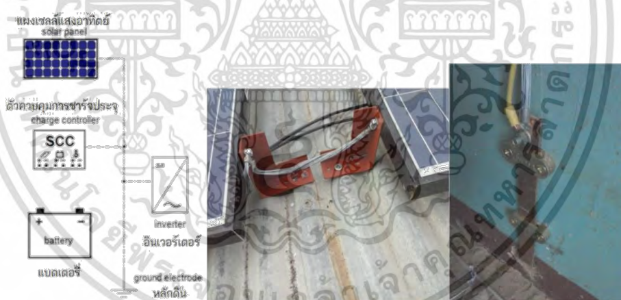
รูปที่ 2.33 การต่อสายดิน [20]
