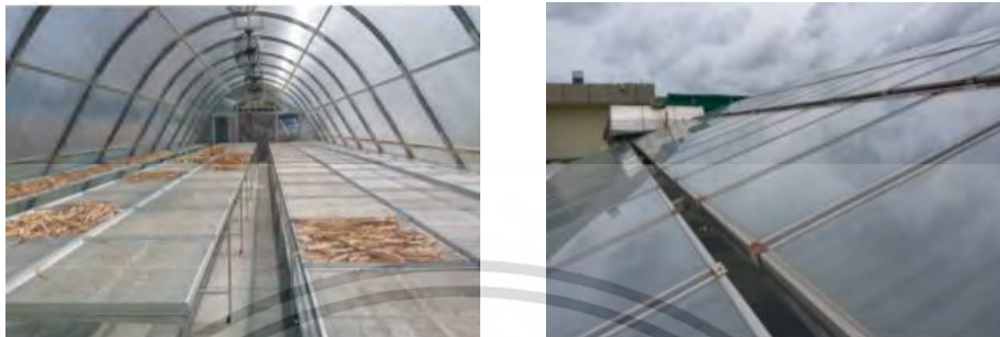
รูปที่ 2.6 การใช้พลังงานความร้อนที่ได้จากแสงอาทิตย์ในการใช้งานระบบอบแห้งและระบบทำน้ำร้อนพลังงานแสงอาทิตย์ [16]
