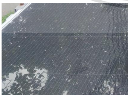
(ก) แผงโซลาร์เซลล์ที่ยังไม่ได้ทำความสะอาด
