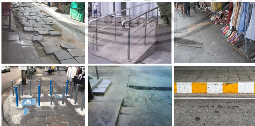
รูปที่ 1.1 สิ่งกีดขวางในการเดินทางกลางแจ้งสำหรับผู้ใช้รถเข็น
