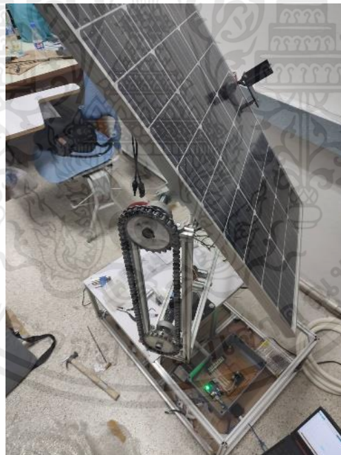
รูปที่ 3.14 ติดตั้งวงจรเข้าโครงสร้างของชิ้นงาน
