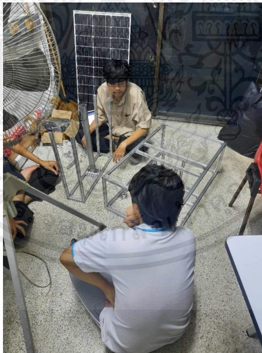
รูปที่ 6 ประกอบโครงสร้างของชิ้นงาน
