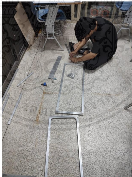
รูปที่ 4 การประกอบโครงสร้างของชิ้นงาน
