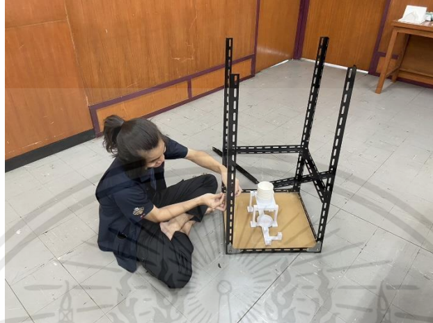
รูปที่ 3.29 ประกอบโครงด้วยเหล็กฉาก
