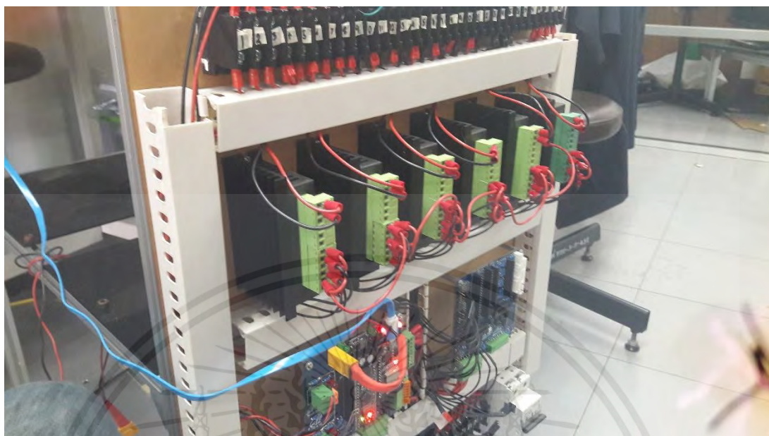
รูปที่ 3.44 การ Wiring สายไฟ
