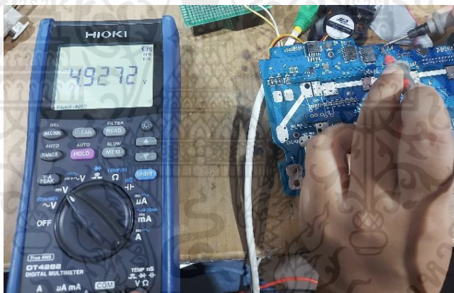
รูปที่ 4.3 การวัดค่าแรงดันไฟฟ้าของยูเอสบี
