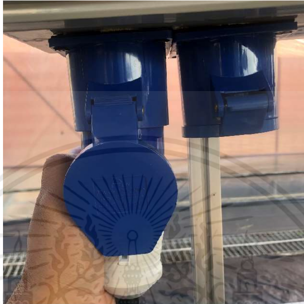
รูปที่ ก.1 ต่อปลั๊กส่วนของไฟเลี้ยงระบบควบคุมเข้ากับกล่องควบคุม
