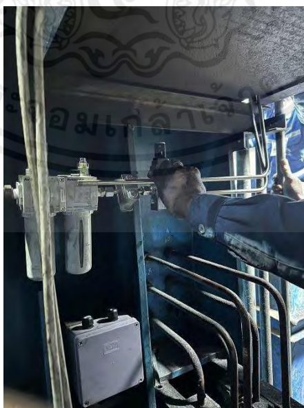
รูปที่ 3.11 ติดตั้งชุดท่อลมและวาล์วลม
