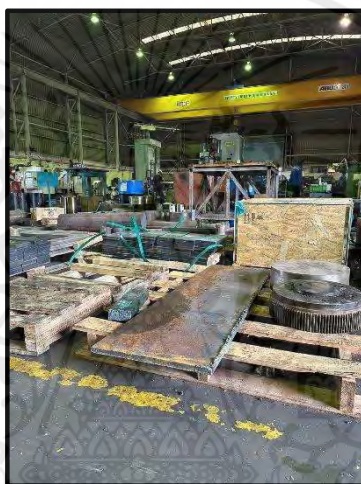
รูปที่ 3.7 ส่งเหล็กไปขึ้นรูปชิ้นส่วนโดยการใช้เครื่องตัดเหล็กซึ่งตัดตามขนาดแบบสองมิติ
