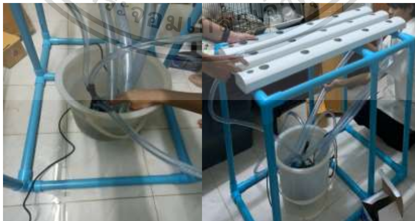
ภาพที่ ก.2 การนำระบบ NFT มาประกอบเข้ากับแปลงและฐาน
