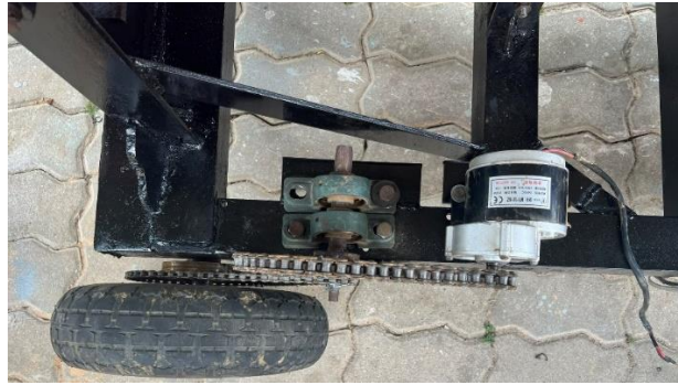
รูปที่ 3.24 การติดตั้งมอเตอร์ไฟฟ้ากับเฟืองโซ่
