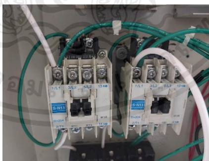
รูปที่ 3.14 แมกเนติกคอนแทคเตอร์ (Magnetic contactor) 20A 220-240 V
