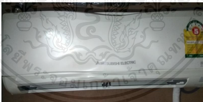
รูปที่ 3.4 ชุดอีวาพอเรเตอร์ ทำหน้าที่ดูดซับความร้อนและให้ความเย็นภายในห้อง
