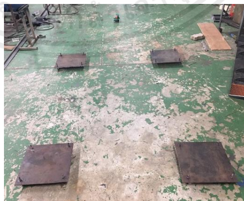
รูปที่ 3.25 ติดตั้งเครื่องวัดระดับเลเซอร์ และ แท่นระดับ
