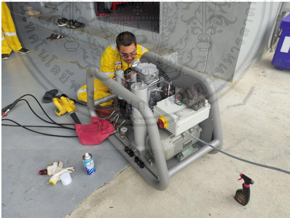
รูปที่ ก.2 ตรวจสอบเครื่องอัดอากาศ SCBA
