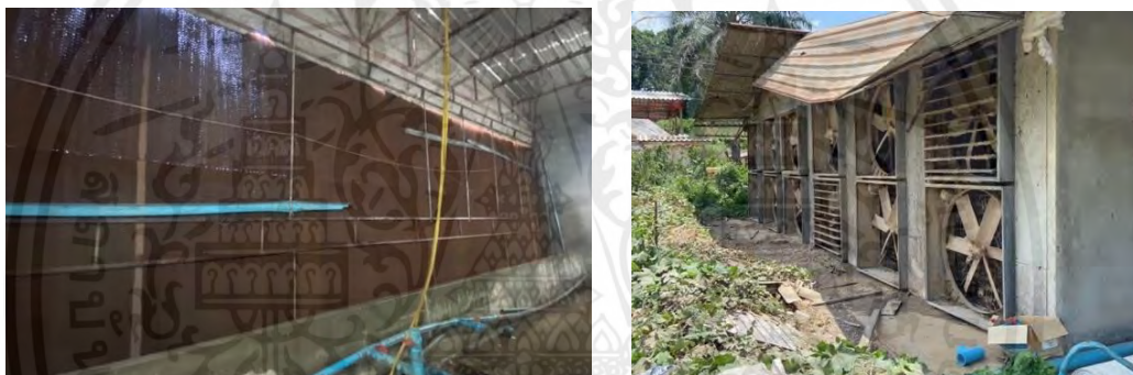
ภาพที่ 4.9 ระบบอีแวปและพัดลมดูดอากาศภายในโรงเรือน
