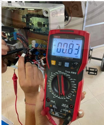
รูปที่ 4.13 ภาระทางไฟฟ้าในช่วง 50 โอห์ม กระแสทางด้านเอาพุต 0.83 แอมป์
