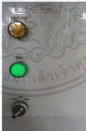
รูปที่ ข.2 ปรับสวิตช์ไปที่ MAN
