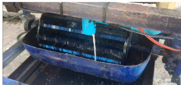
รูปที่ 4.11 มอเตอร์ไฟฟ้ากระแสดตรงที่ตัวกวณ และตัวปล่อยน้ำขณะทำงาน
