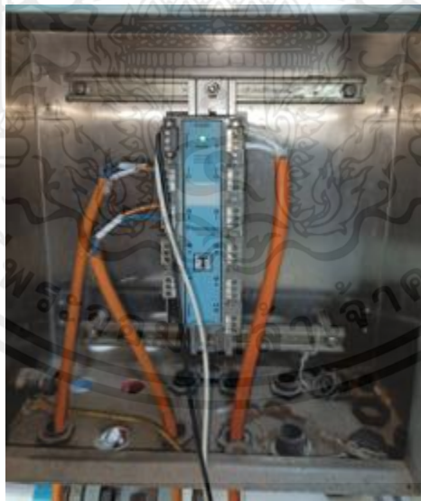
รูปที่ 3.36 ภายในกล่องเชื่อมต่อสาย
