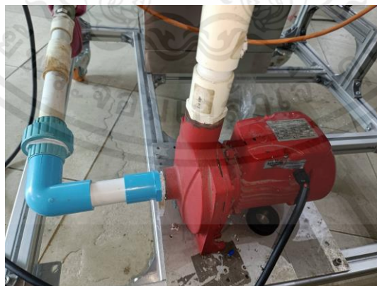
รูปที่ 3.31 การติดตั้งปั้มน้ำ
