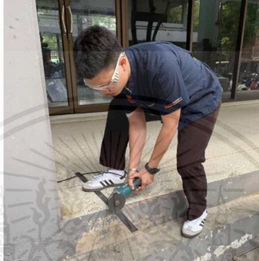
รูปที่ 3.34 ตัดเหล็กเพื่อที่จะนำมาทำ U-box ใส่แบตเตอรี่
