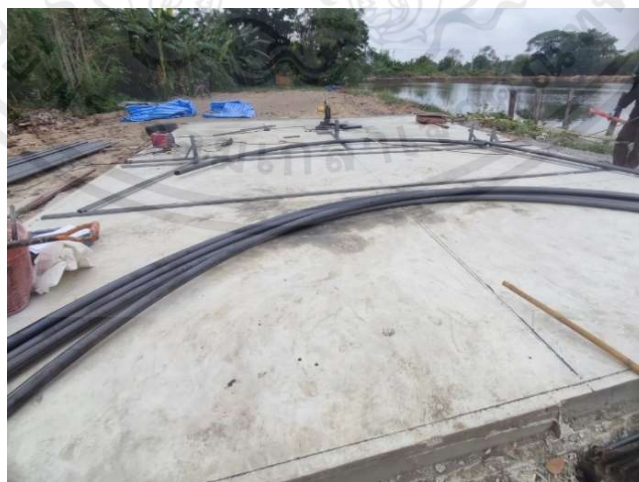
รูปที่ 3.11 ตัดส่วนโค้งของโรงอบแห้ง
