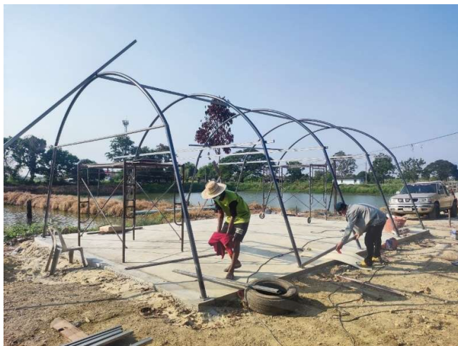
รูปที่ 3.12 เริ่มทำการสร้างโครงสร้างโรงอบแห้ง
