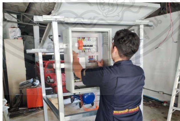
รูปที่ 3.26 ติดตั้งตู้ระบบกำลังไฟฟ้า
