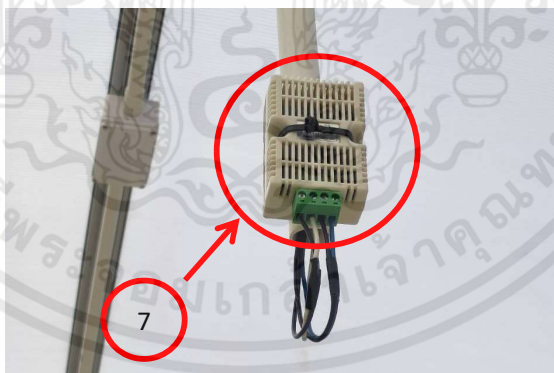
รูปที่ 3.30 เซนเซอร์วัดอุณหภูมิและความชื้นภายในโรงอบแห้ง
