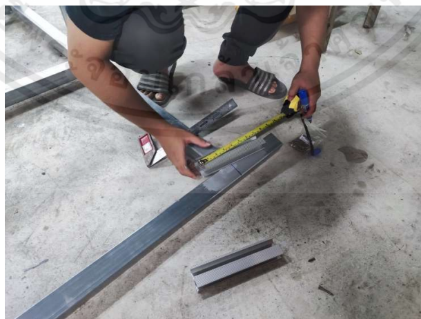
รูปที่ 3.23 วัดขนาดหามุมติดตั้งโซล่าเซลล์
