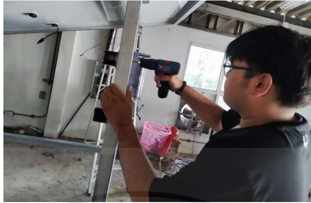
รูปที่ 3.24 ติดตั้งแผงโซลาร์เซลล์กับฐาน
