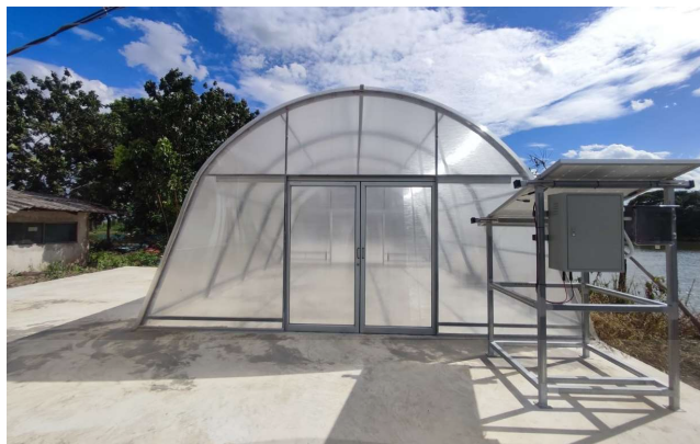
รูปที่ 4.3 ด้านหลังโรงอบแห้งพลังงานแสงอาทิตย์
