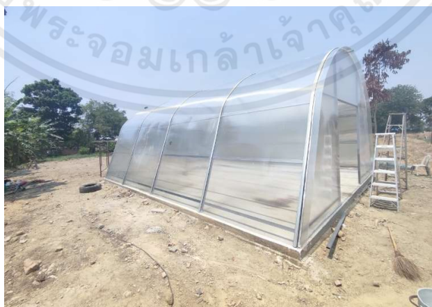
รูปที่ 3.14 หลังติดตั้งโพลีคาร์บอนเนต
