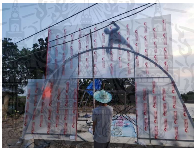
รูปที่ 3.13 ติดตั้งโพลีคาร์บอนเนต
