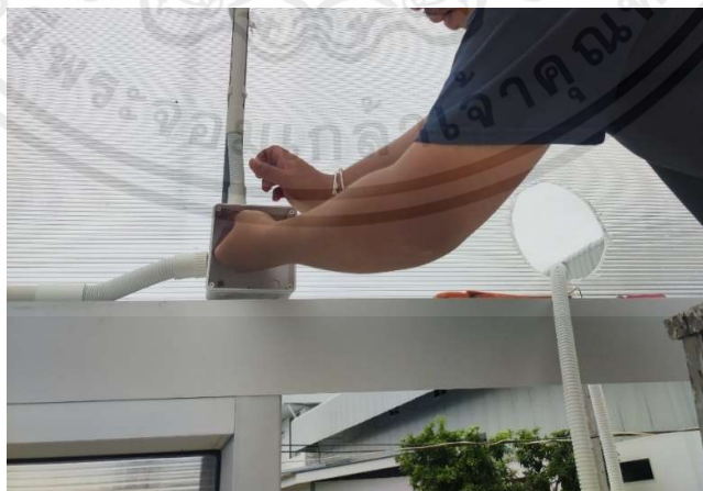
รูปที่ 3.17 ติดตั้งท่อเดินสายไฟสำหรับระบบควบคุม
