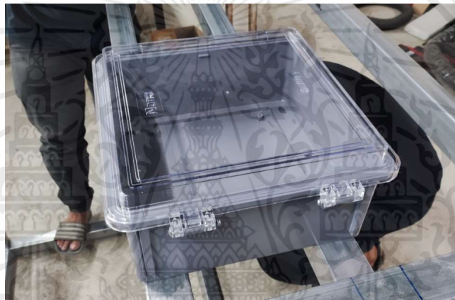
รูปที่ 3.25 ติดตั้งตู้ระบบควบคุม
