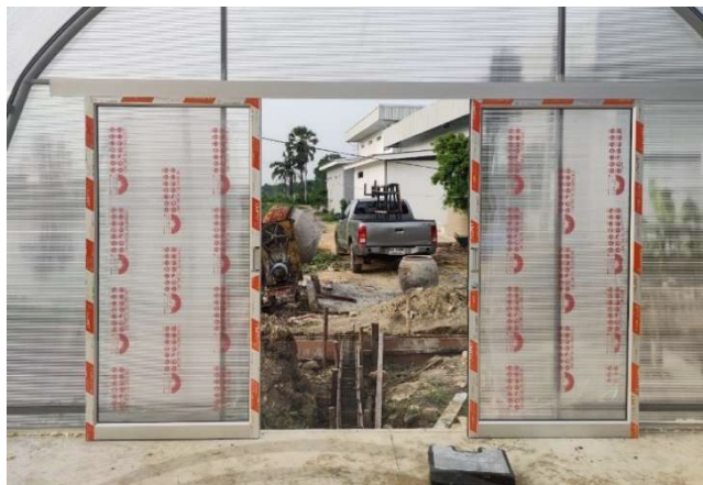
รูปที่ 3.15 ติดตั้งประตูภายในโรงอบแห้ง
