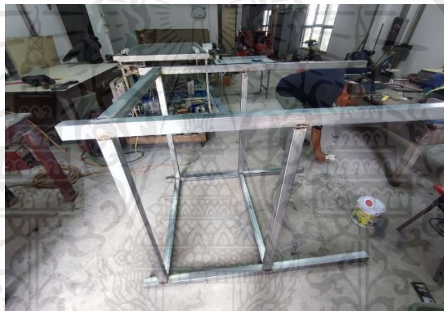
รูปที่ 3.22 ทำการเชื่อมโครงสร้างฐาน
