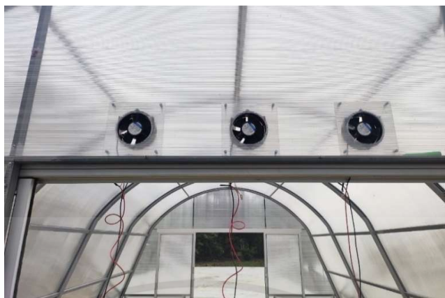
รูปที่ 3.18 ติดตั้งพัดลมระบายอากาศ
