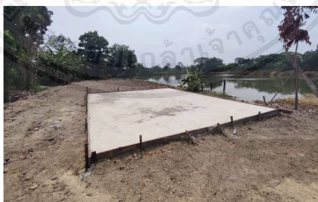
รูปที่ 3.8 สำรวจพื้นที่
