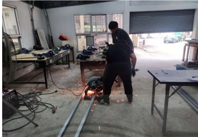
รูปที่ 3.21 ตัดเหล็กเพื่อทำฐานโซล่าเซลล์
