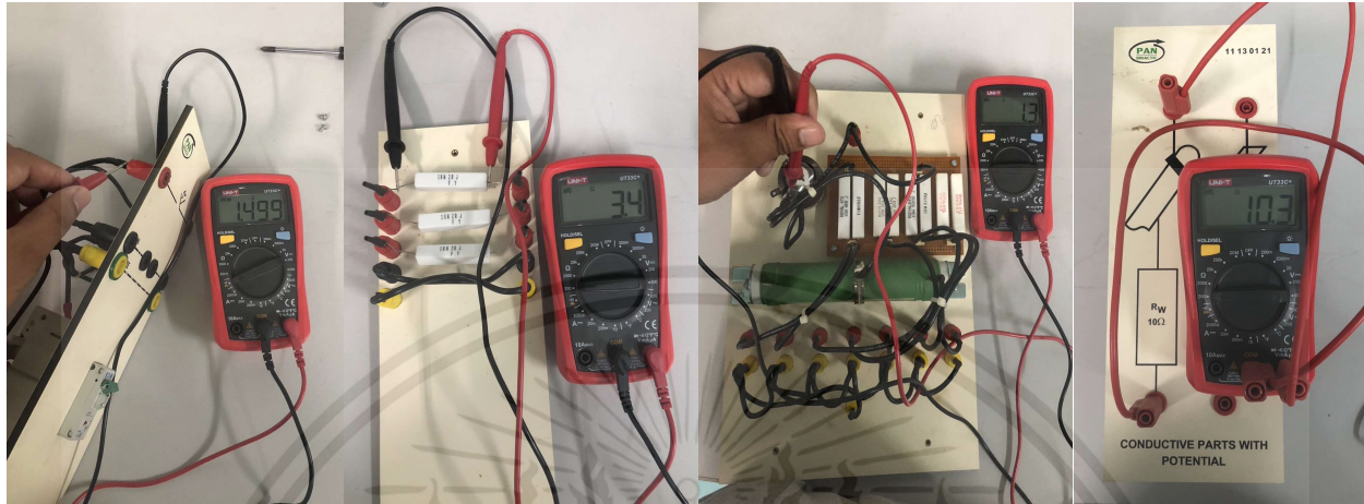
รูปภาพที่ 3.22 แสดงถึงการตรวจสอบอุปกรณ์ชุดทดลองระบบป้องกันอันตรายจากระบบไฟฟ้า
