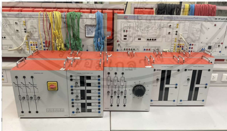
รูปภาพที่ 4.11 หม้อแปลงไฟฟ้าทั้ง 11 ตัว
