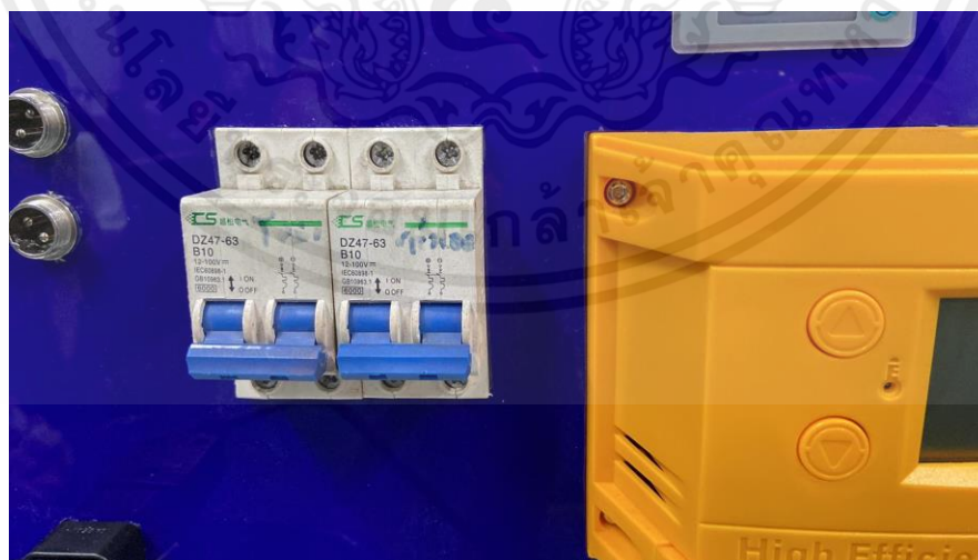
รูปที่ ก3. ปิดเซอร์กิตเบรกเกอร์โซล่าเซลล์ชาร์จเจอร์
