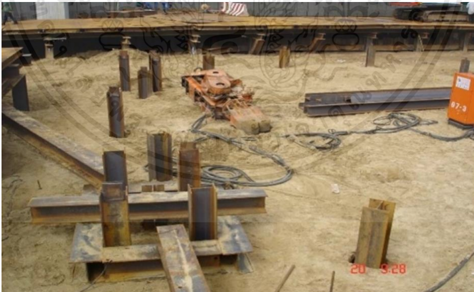
รูปที่ 3.8 ก่อสร้างเสาเข็มเหล็ก (Steel King Post)
