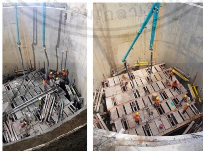
รูปที่ 3.16 การติดตั้ง Plat Form และการเท Concrete Plug
