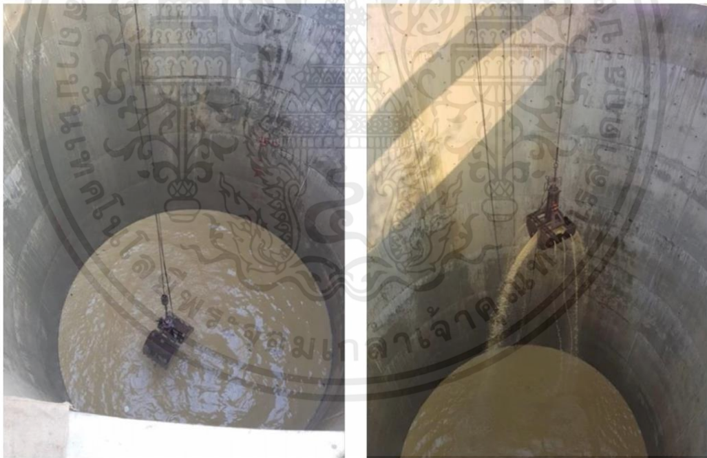
รูปที่ 3.14 ขุดดินกรณีใต้น้ำ
