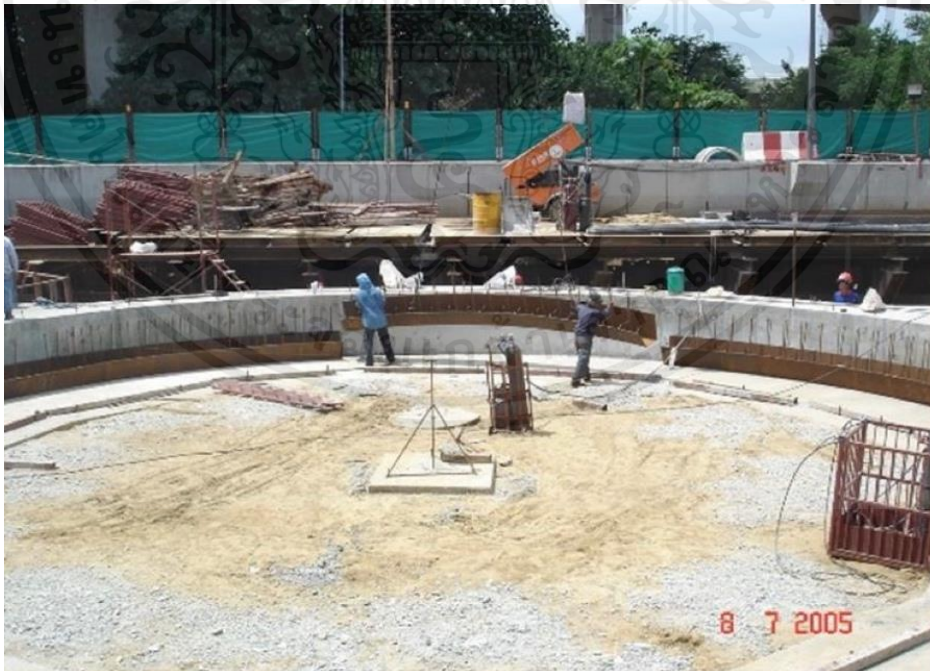
รูปที่ 3.10 การติดตั้งชิ้นงานวงเหล็กชั้นแรก (Steel Cutting Shoe)
