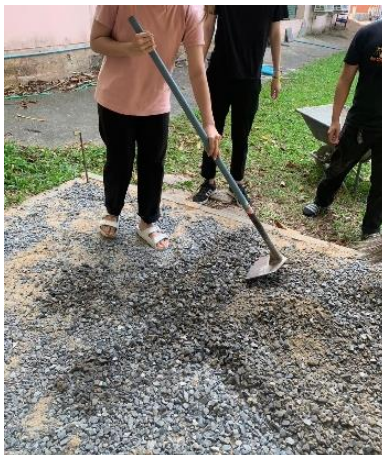
รูปที่ 3.11 ปรับระดับพื้นสนามทดสอบด้วยกรวด
