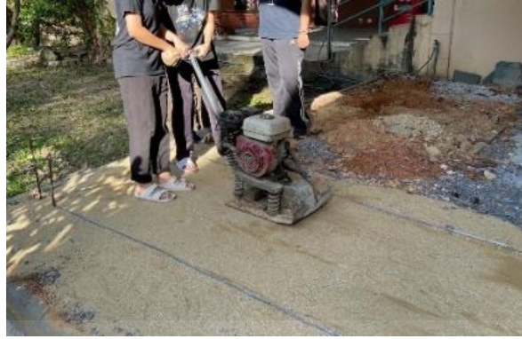
รูปที่ 3.12 การบดอัดดิน
