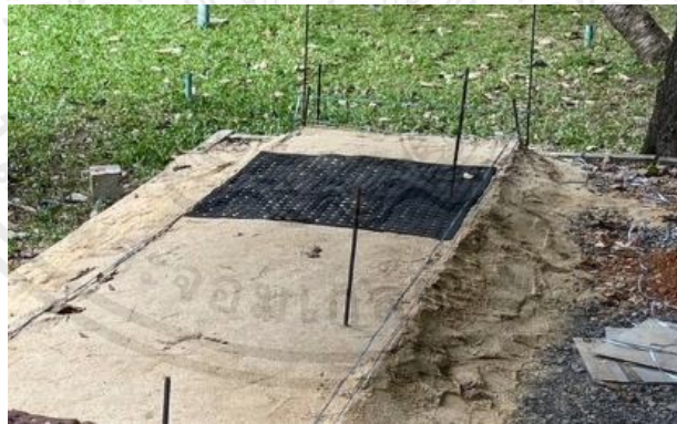
รูปที่ 3.14 การใส่แผ่นยางคอมพาวด์
