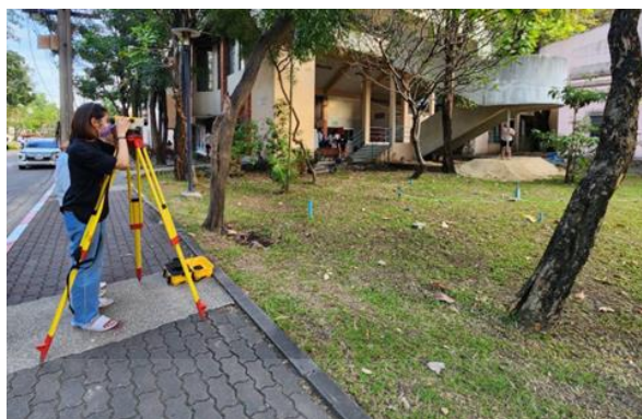
รูปที่ 3.19 การวัดค่าการทรุดตัว
