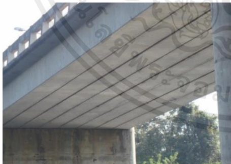
รูปที่ 2.28 ระบบพื้นสะพานแบบคอนกรีตอัดแรงรูปกล่อง
