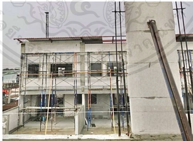
รูปที่ 3.14 ทาวนโฮมโครงการเบเวอร์ลี่ ฮิลส์ ร่มเกล้า โดยวิธีการก่อแบบตั้งเดิมด้วยอิฐมวลเบา
