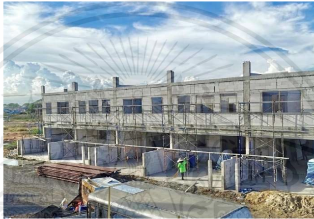
รูปที่ 3.8 ทาวนโฮมโครงการศุภาลัย พรีเมียม ลาดกระบัง โดยวิธีการก่อแบบดั้งเดิมด้วยอิฐมวลเบา
