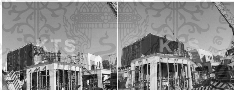
รูปที่ 2.17 การยกชิ้นงาน Tunnel Form (บริษัท เค.ไทย สตีลเวิร์ค จำกัด, 2559)
