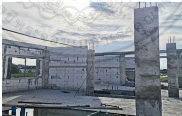
รูปที่ 3.9 ทาวนโฮมโครงการศุภาลัย พรีเมียม ลาดกระบัง โดยวิธีการก่อแบบดั้งเดิมด้วยอิฐมวลเบา
