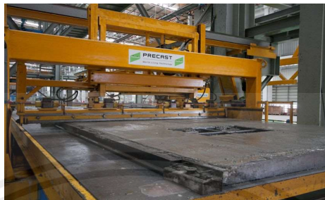
รูปที่ 2.12 การเทคอนกรีต (Pruksa Real Estate, 2015)
