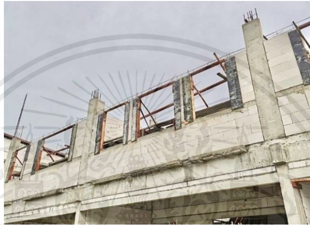
รูปที่ 3.13 ทาวนโฮมโครงการเบเวอร์ลี่ ฮิลส์ ร่มเกล้า โดยวิธีการก่อแบบตั้งเดิมด้วยอิฐมวลเบา
