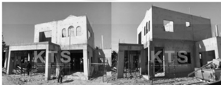
รูปที่ 2.18 การเทคอนกรีตลงใน Tunnel Form (บริษัท เค.ไทย สตีลเวิร์ค จำกัด, 2559)
