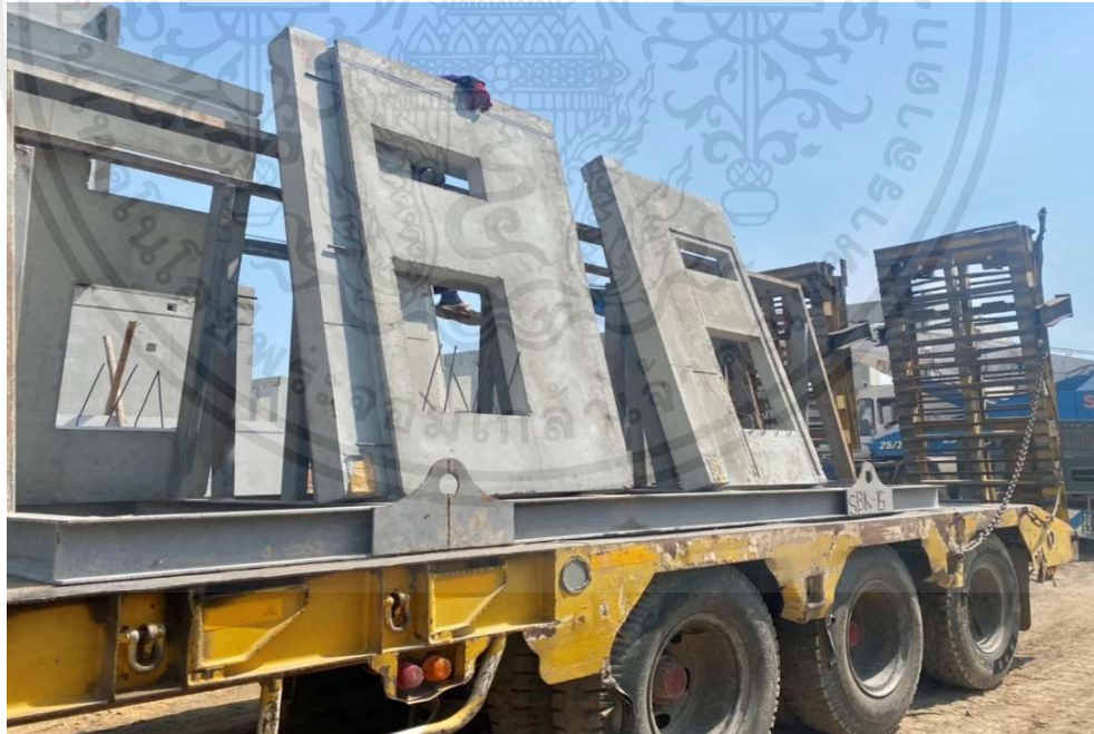
รูปที่ 3.4 ชิ้นส่วนคอนกรีตสำเร็จรูปของโครงการมณฑนา บางนา กม.15 Type 172 (พื้นที่งานผนัง 131.14 ตร.ม.) โดยวิธีการใช้ชิ้นส่วนคอนกรีตสำเร็จรูป
