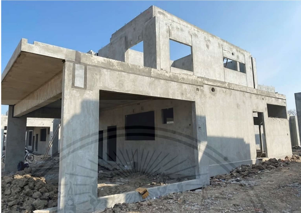
รูปที่ 3.3 บ้านเดี่ยวด้านข้างโครงการมณฑนา บางนา กม.15 Type 172 (พื้นที่งานผนัง 131.14 ตร.ม.) โดยวิธีการใช้ชิ้นส่วนคอนกรีตสำเร็จรูป
