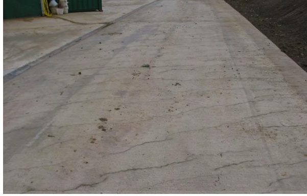
รูปที่ 2.2 การเกิด Drying Shrinkage Crack ของคอนกรีตโครงสร้างพื้น
