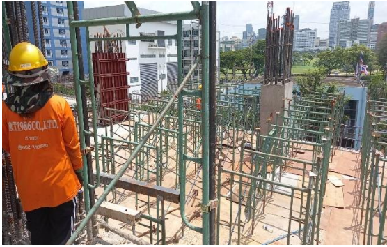
รูปที่ 4.13 การตั้งนั่งร้านรับแรง
