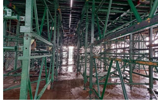
รูปที่ 4.13 การตั้งนั่งร้านรับแรง
