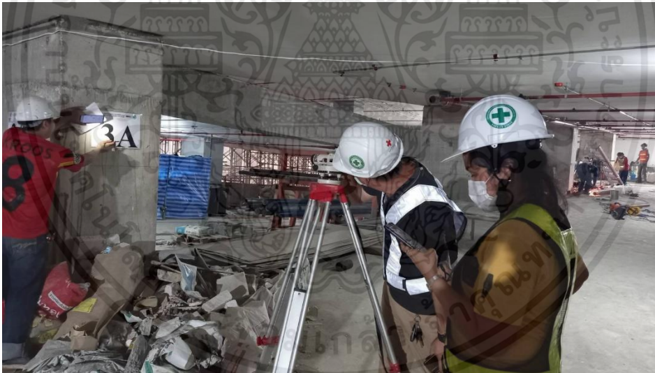
รูปที่ ค.2 ตรวจสอบระดับของพื้นหลังเทคอนกรีต
