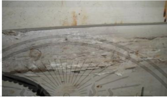
รูปที่ 2.10 การแตกร้าวเนื่องจากการตกผลึกของเกลือ (CPAC หนังสือ Concrete Technology, 2000)
