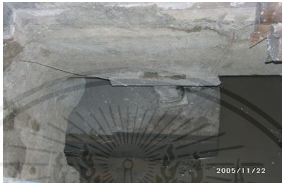
รูปที่ 2.6 การแตกร้าวของผนังกำแพงเนื่องจากการหดตัวของบ่อโตนินส์ (PSPCEMENTMIN, การหดตัวของคอนกรีต, 2559)
