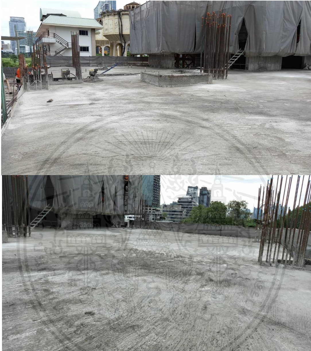
รูปที่ ก.6 พื้นหลังเทคอนกรีต
