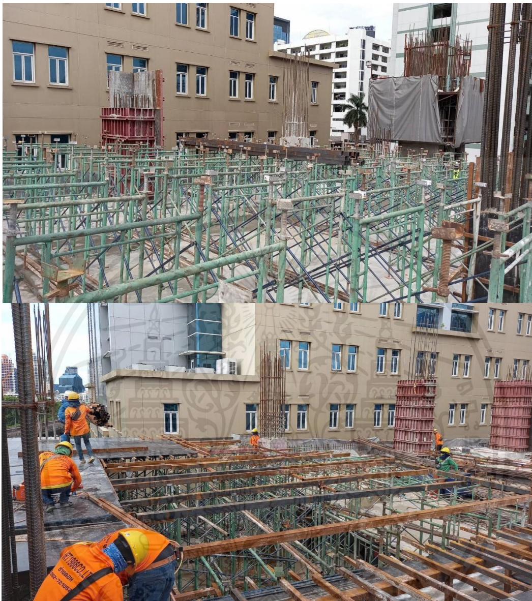
รูปที่ ก.3 การตั้งนั่งร้านรับพื้นหน้างาน
