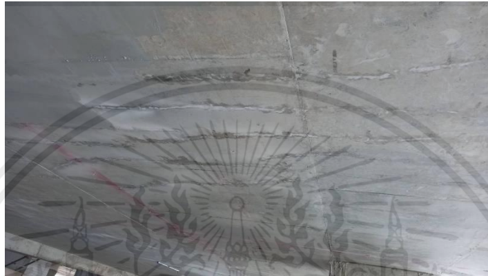
รูปที่ 2.23 รอยร้าวที่บริเวณใต้ท้องพื้นไร้คานเป็นแนวขนานกับด้านสั้นของแผ่นพื้น
