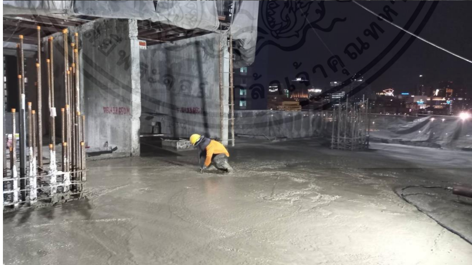
รูปที่ ก.5 การเทคอนกรีตพื้นหน้างาน
