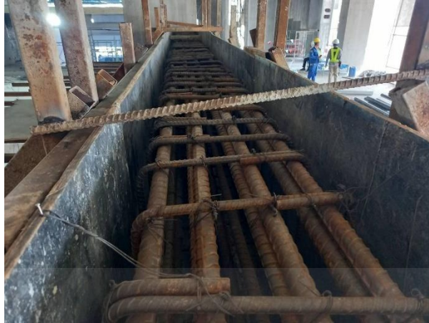
รูปที่ 2.3 การเกิดปฏิกิริยาคาร์บอนไดออกไซด์ที่ทำให้คอนกรีตเกิดสนิม
