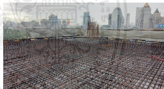
รูปที่ 4.14 การจัดวางเหล็กโครงสร้าง
