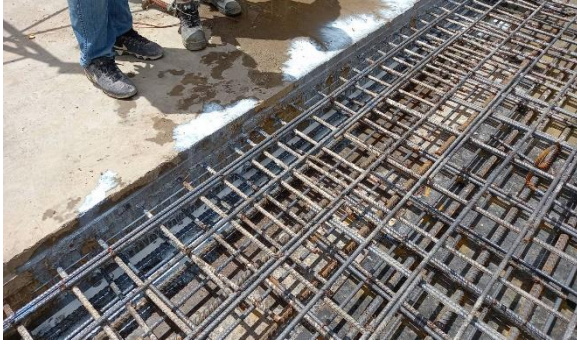
รูปที่ 4.15 การแบ่งเขตคอนกรีตและการปมคอนกรีต
