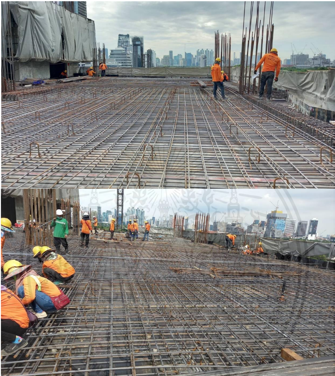
รูปที่ ก.4 การจัดวางเหล็กโครงสร้างพื้นงาน
