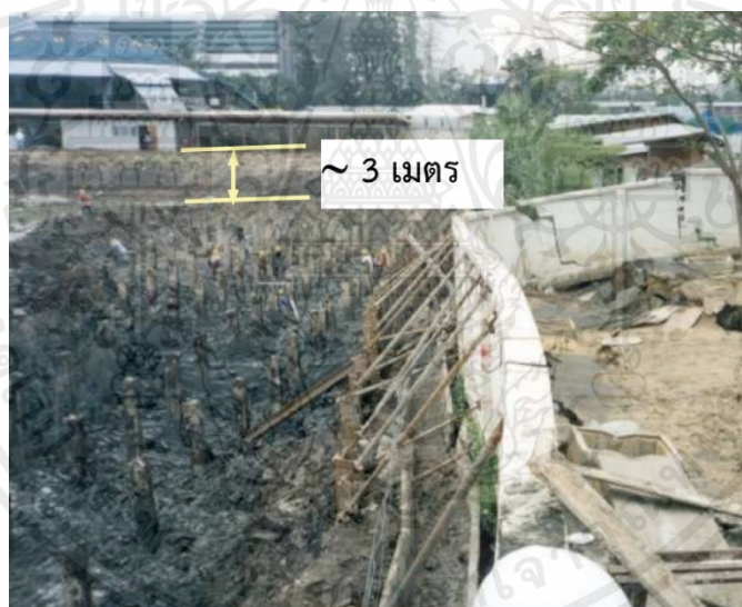
รูปที่ 2.23 ในดินที่มีกำลังรับแรงเฉือนต่ำ (ดินเหนียวอ่อน)
