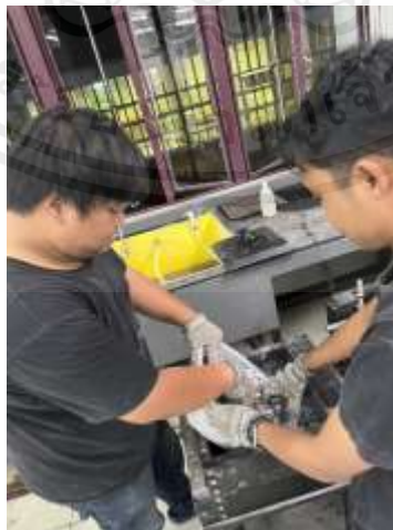
รูปที่ 3.25 นำหินคลุกมาเททับบริเวณแผ่นยางคอมปาวด์
