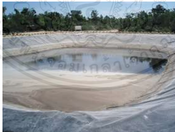
รูปที่ 2.4 แผ่นวัสดุสังเคราะห์ที่บ่งน้ำที่นำมาป้อนน้ำชะขยะ
