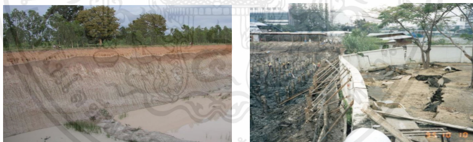
(a) ชั้นดินลูกรังขุดดิน (b) ชั้นดินเหนียวอ่อนกรุงเทพขุดลึกประมาณ 3
