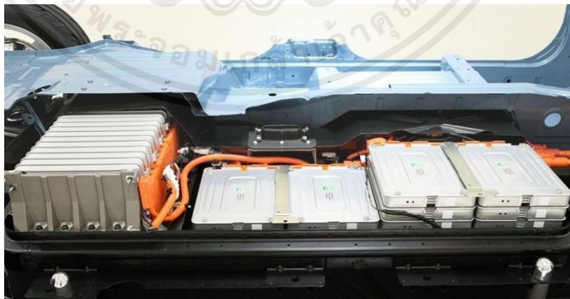
รูปที่ 2.17 แบตเตอรี่ที่เรียงกันอยู่บริเวณฐานของตัวถังของรถยนต์ไฟฟ้า
