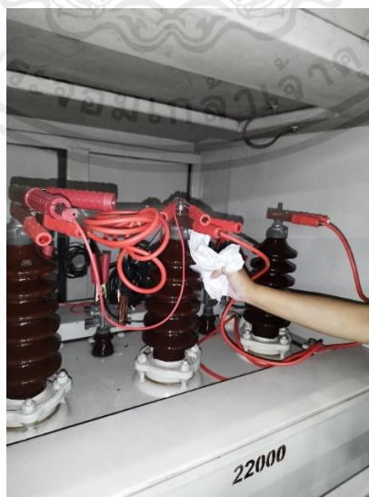
รูปที่ 3.6 ทำความสะอาดบุชชิ่ง ทำการลัดวงจรขั้วแรงดันสูง และขั้วแรงดันต่ำของหม้อแปลงไฟฟ้า
