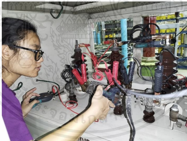
รูปที่ 3.8 ต่อสายการวัดเข้ากับหม้อแปลงไฟฟ้า
