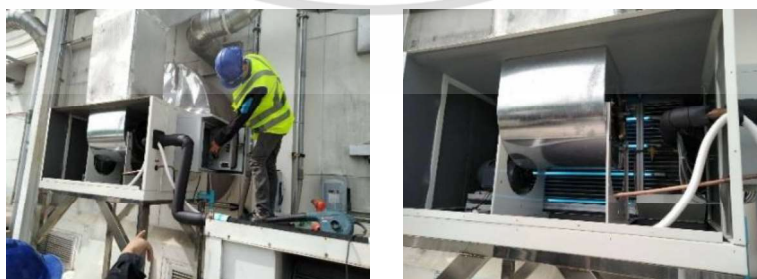
รูปที่ 2.28 การติดตั้งระบบ UVGI ใน AHU
