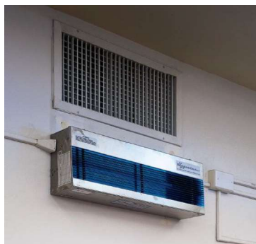
รูปที่ 2.29 การติดตั้งระบบ UVGI ชนิดติดตั้งที่ผนัง
