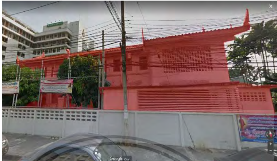
รูปที่ 3.2 แสดงภาพถ่ายด้านนอกของตึกสงฆ์อาพาธ (ทิศเหนือติดกับถนนบ้านห้อย) ที่มา: google street map (เข้าถึง 25 มิถุนายน 2565) และผู้วิจัย (2566)
