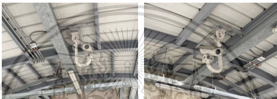
ภาพที่ 4.60 การติดตั้งกล้องวงจรปิดภายในพื้นที่ห้าแยกลาดพร้าว (ที่มา : ผู้ศึกษา)
