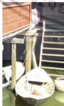
รูปที่ 5.28 บันไดไม้ (ที่มา : ผู้วิจัย. 2564)
