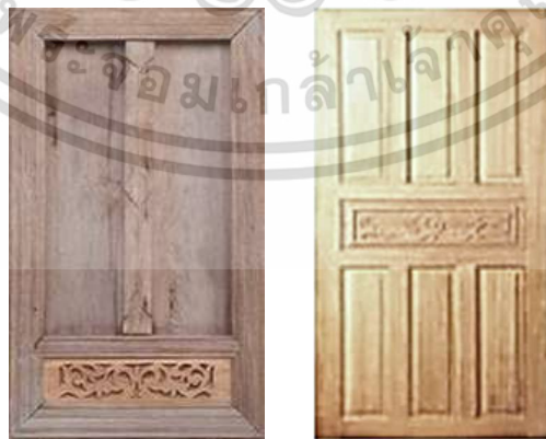
รูปที่ 5.11 หน้าต่างไม้ลูกฟักบานเปิดเดี่ยว และหน้าต่างไม้บานเปิดคู่ แบบไทยเดิม (ที่มา : ผู้วิจัย. 2564)
