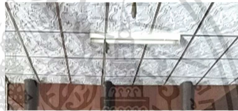
รูปที่ 5.23 เพดานไขว้โครงสร้างหลังคา และกรุยิปซัมพิมพ์ลายสีชาว (ที่มา : ผู้วิจัย. 2564)
