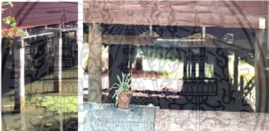
รูปที่ 5.19 เสาปูนเหลี่ยม และเสากลมไม้จริง (ที่มา : ผู้วิจัย. 2564)
