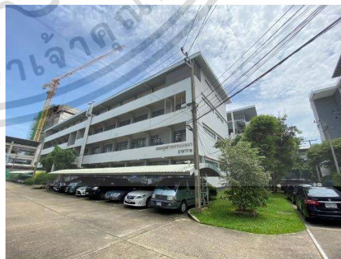
รูปที่ 4.29 บริเวณโดยรอบอาคาร 2
