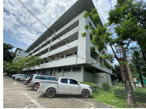
รูปที่ 4.31 บริเวณโดยรอบอาคาร 2
