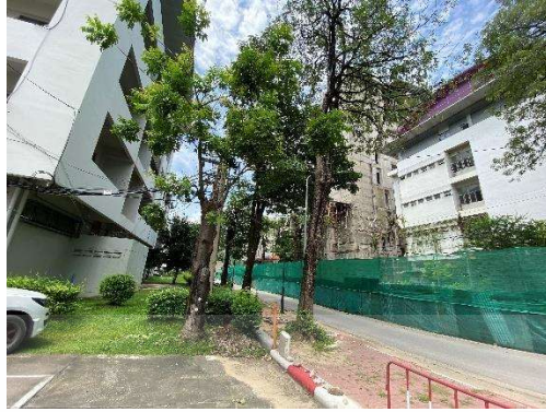
รูปที่ 4.30 บริเวณโดยรอบอาคาร 2
