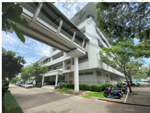
รูปที่ 4.28 บริเวณด้านหน้าอาคาร 2 และสะพานทางเชื่อมอาคาร
