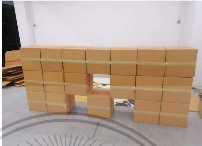
ภาพที่ 3.5 วางเรียงกล่องกระดาษลูกฟูกกรอบแผ่นไฟเบอร์ซีเมนต์
