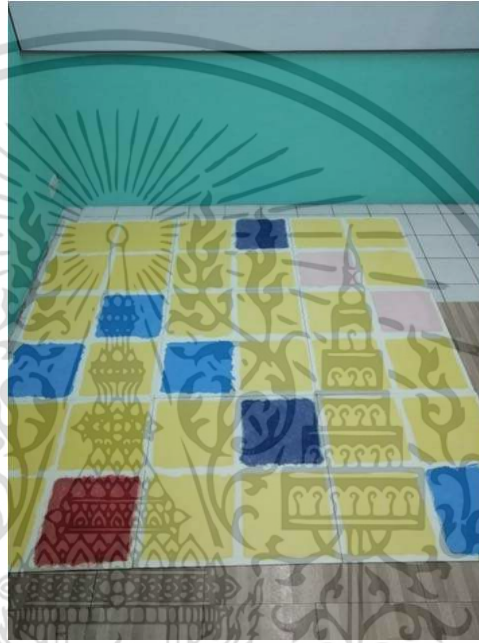
ภาพที่ 3.12 วางเรียงแผ่นไฟเบอร์ซีเมนต์และทาสี
