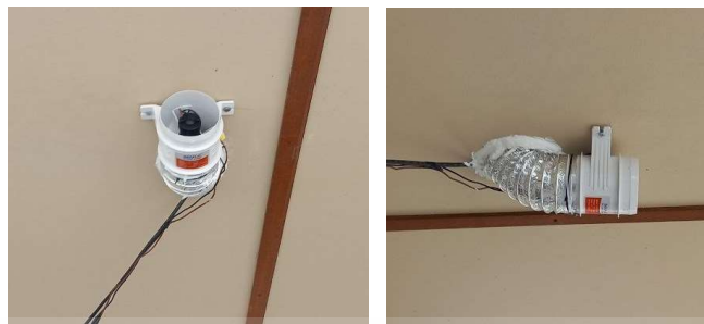
รูปที่ 4.17 แสดงการติดตั้งพัลลภระบายอากาศที่ผ้าชายคาทิศตะวันตก (ที่มา: ผู้วิจัย, 2565)
