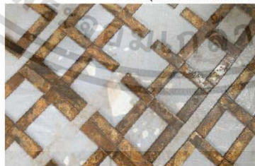
ภาพถ่ายจากมุมบนของชั้นเหล็ก "C"
