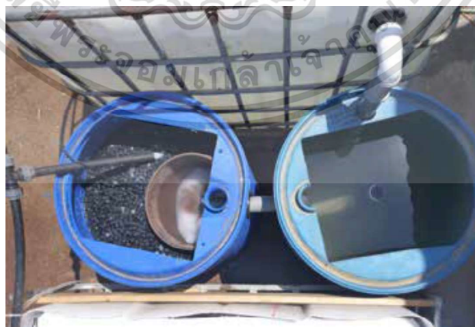
รูปที่ 2.21 ตัวอย่างขั้นตอนวางตำแหน่งถังกรองชีวภาพ ที่มา: Somerville (2014)
