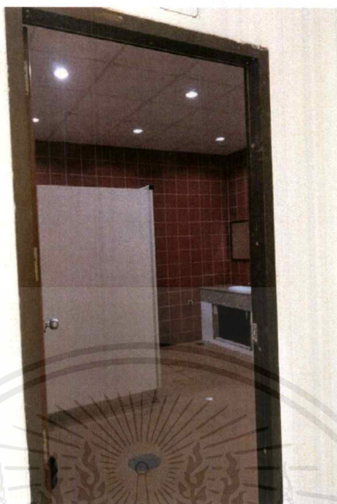
รูปที่ 4.20 ภาพแสดงหลอดไฟบริเวณภายในห้องน้ำ
