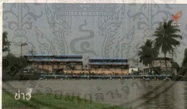
รูปที่ 2.3 สถานีสูบน้ำดิบสำแล จ.ปทุมธานี
